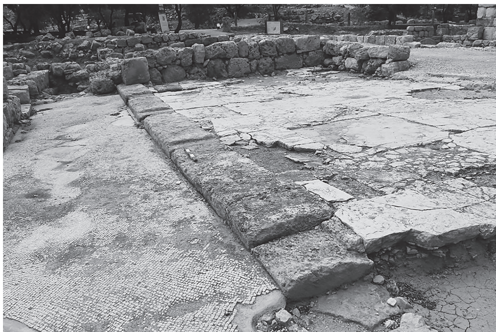
Ил. 9. Углубления на стилобатах для фиксации плитов. Фото С. Тархановой, 2016 г.
