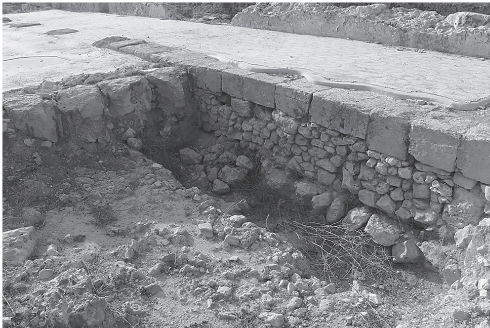
Ил. 11. Основание из крупных булыжников и камней среднего размера под стилобатом декуманоса. Северная часть вимы поздней северной церкви. Фото С. Тархановой, 2016 г.
