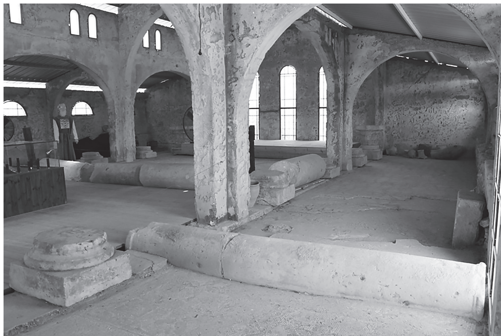
Ил. 17. Фуст колонны в базиликальной церкви, найденный во вторичном использовании в качестве порога. Фото С. Тархановой, 2016 г.
