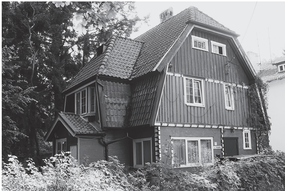
Ил. 12. Светлогорск. Деревянный дом. Арх. М. Шёнвальд (?), 1908 г. Фото С. Шевченко, 2018
