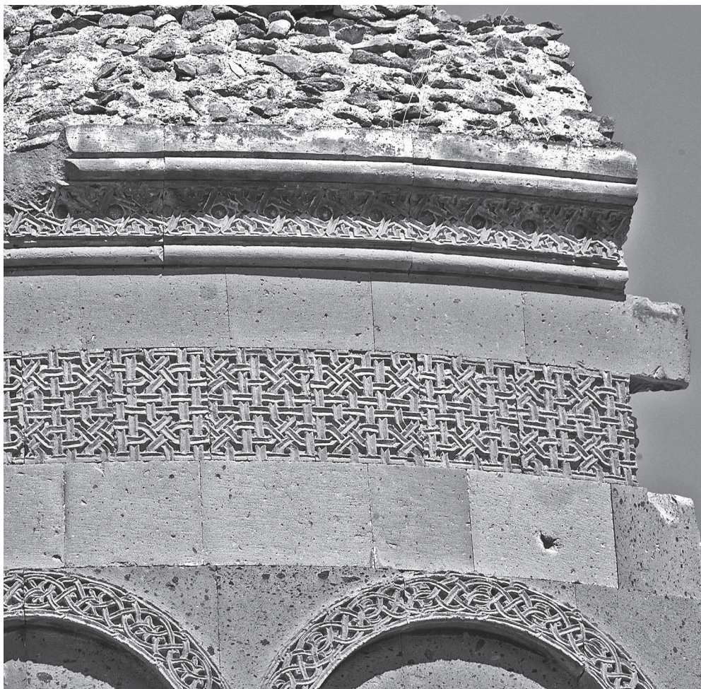
Ил. 6. Церковь Спасителя в Ани. Завершение южной стороны барабана. Фото А. Казаряна, 2012 г.
