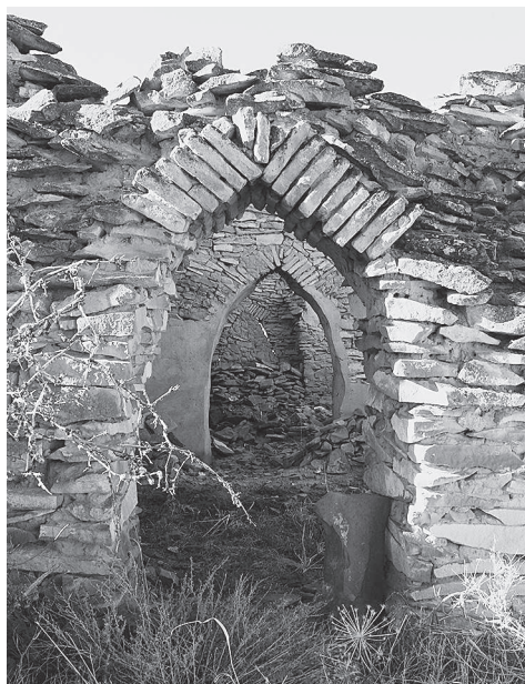
Ил. 18. Урочище Пақыр-ших. Мавзолей №3. Дверные проёмы с ланцетовидными арками. Фото Р.Г. Мурадова, 2016 г.
