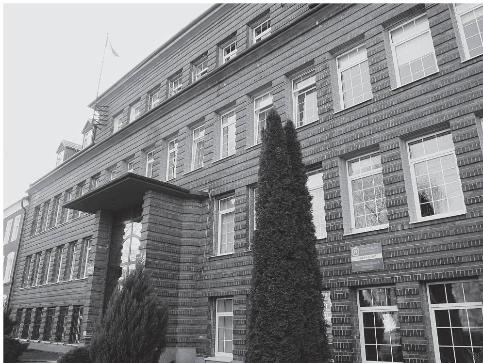
Ил. 16. Гусев/Гумбиннен. Бывш. здание управления восточно-прусских заводов, ныне — городская администрация. Арх. и дата строительства не выявлены. Фото И. Белинцевой, 2019 г.
