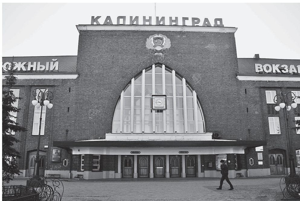
Ил. 10. Калининград/Кёнигсберг. Южный вокзал (бывший Главный вокзал на Рейхсплац, 1929 г., проект отдела наземного строительства управления железных дорог в Берлине, рук. арх. Корнелиус). Фото И. Белинцевой, 2017 г.
