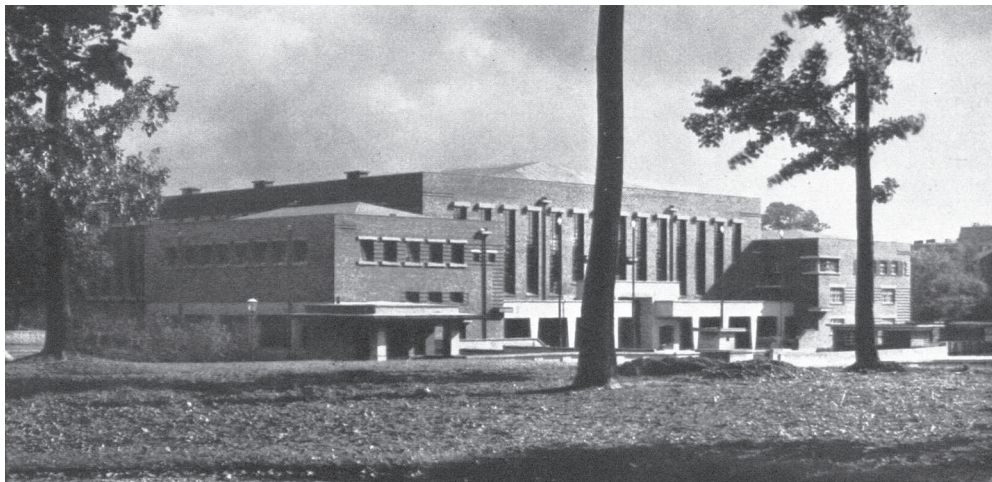
Ил. 3. Калининград/Кёнигсберг. Дом Техники. Арх. Г. Хопп. 1924–1925 (Fischer Kurt 1929)
