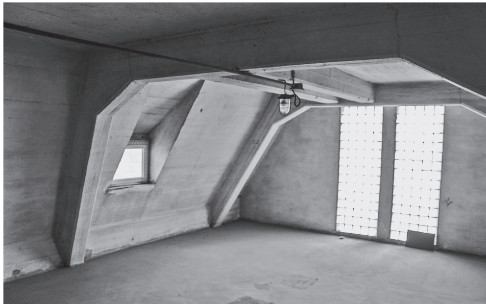
Ил. 15. Кёнигсберг. Портовые элеватор, 1942. Железобетонная конструкция перекрытия. Фото Е. Мосиенко, 2019
