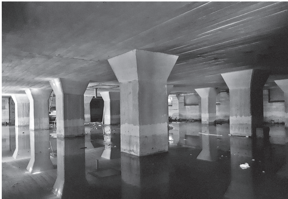
Ил. 9. Пройсиш-Эйлау. Один из элеваторов, 1936–1940. Опорные колонны. Фото Е. Мосиенко, 2019
